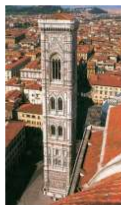
Кампанила или колокольня. Стройная 4-ярусная квадратная башня высотой 84 метра украшена готическими окнами и лишена опорных столбов.
